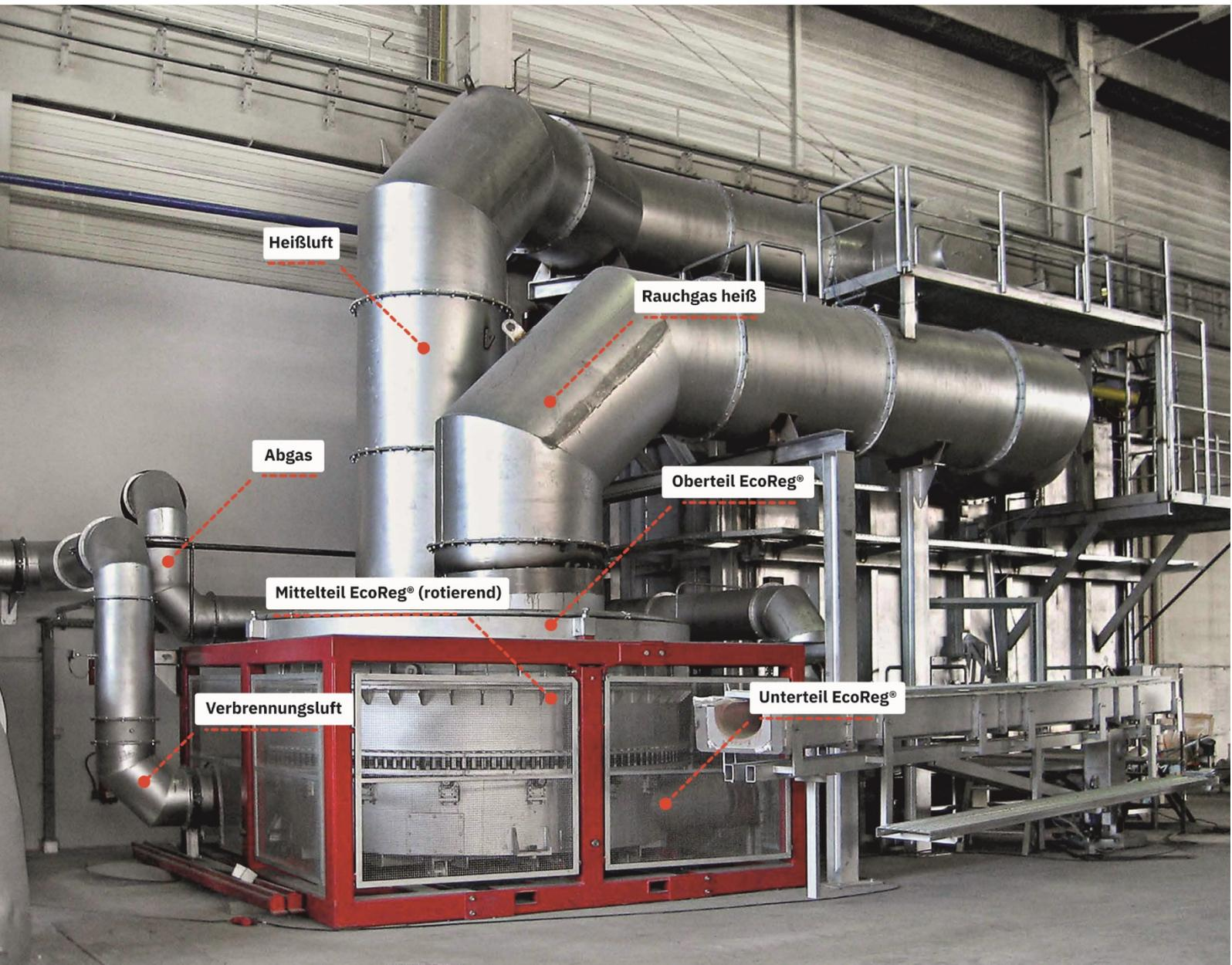
und Abdichtung unterteilt ist. Diese Kammern beinhalten die Wärmespeicherfüllung, die ihre Energie aus dem heißen Ofenabgas bezieht. Die gespeicherte Wärme gelangt durch die Drehung des Mittelteils auf die gegenüberliegende Verbrennungsluftseite.
